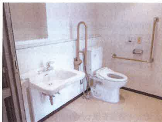
＜客室内トイレ＞
